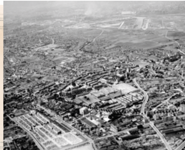
Vue aérienne de l'usine Le Carbone Lorraine de Gennevilliers, années 50-60.
