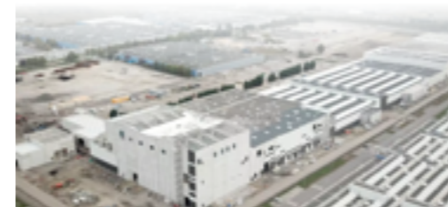
Gigafactory ACC de Douvrin.
